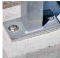
Montage mittels korrosionsbeständigen Schrauben.
